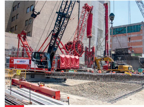
Enceinte et fondations, projet Sullivan 25, Mexico
