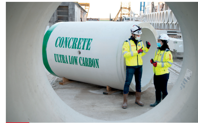
Canalisation de rejet des eaux traitées, station d'épuration, Bonneuil-en-France
